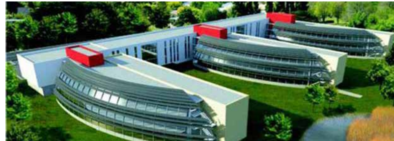
Teknopark Arge Binaları / İSTANBUL
